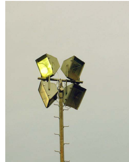
Defekte symmetrische Scheinwerfer mit hohen Streu- lichtverlusten
