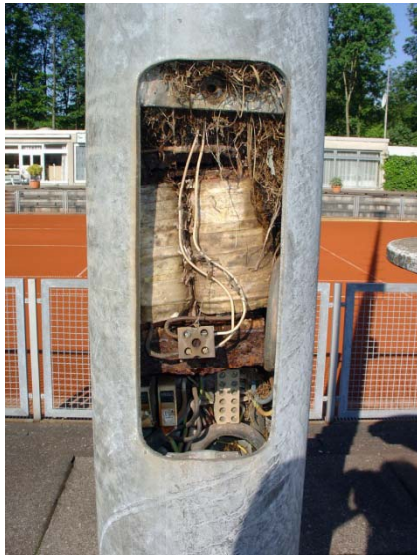
Offene und verrostete Vorschaltgeräte
