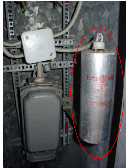
Hochgiftige PCB-haltige Kondensatoren (nicht mehr zulässig seit 12/1999)
